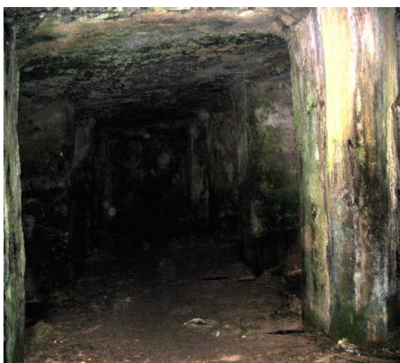
Blick in die Zisternenkammern: Die einzelnen "Räume" der Zisternen erreichen Ausmaße von rd. 40 x 20 m. In Nähe des Eingangsbereiches markiert die Grünfärbung der Pfeiler ein Algenwachstum durch Dauerfeuchtigkeit und Dämmerlicht, unter denen der weiche Kalkstein leidet und an "Stabilität" verliert. Fotos: H. Eikamp (9/2004)
