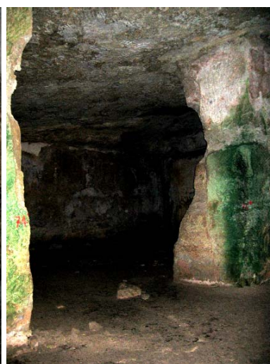
Blick in die Zisternenkammern: Die einzelnen "Räume" der Zisternen erreichen Ausmaße von rd. 40 x 20 m. In Nähe des Eingangsbereiches markiert die Grünfärbung der Pfeiler ein Algenwachstum durch Dauerfeuchtigkeit und Dämmerlicht, unter denen der weiche Kalkstein leidet und an "Stabilität" verliert. Fotos: H. Eikamp (9/2004)
