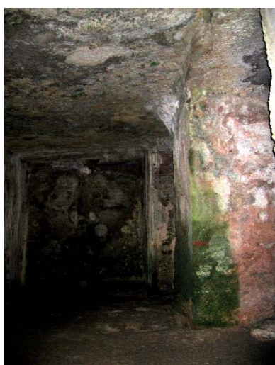
Blick in die Zisternenkammern: Die einzelnen "Räume" der Zisternen erreichen Ausmaße von rd. 40 x 20 m. In Nähe des Eingangsbereiches markiert die Grünfärbung der Pfeiler ein Algenwachstum durch Dauerfeuchtigkeit und Dämmerlicht, unter denen der weiche Kalkstein leidet und an "Stabilität" verliert. Fotos: H. Eikamp (9/2004)
