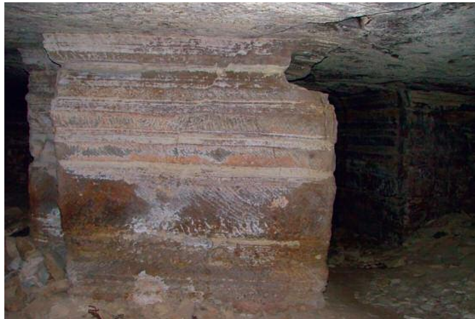
85. Λαβυρινθάκι, στήριξης της οροφής
