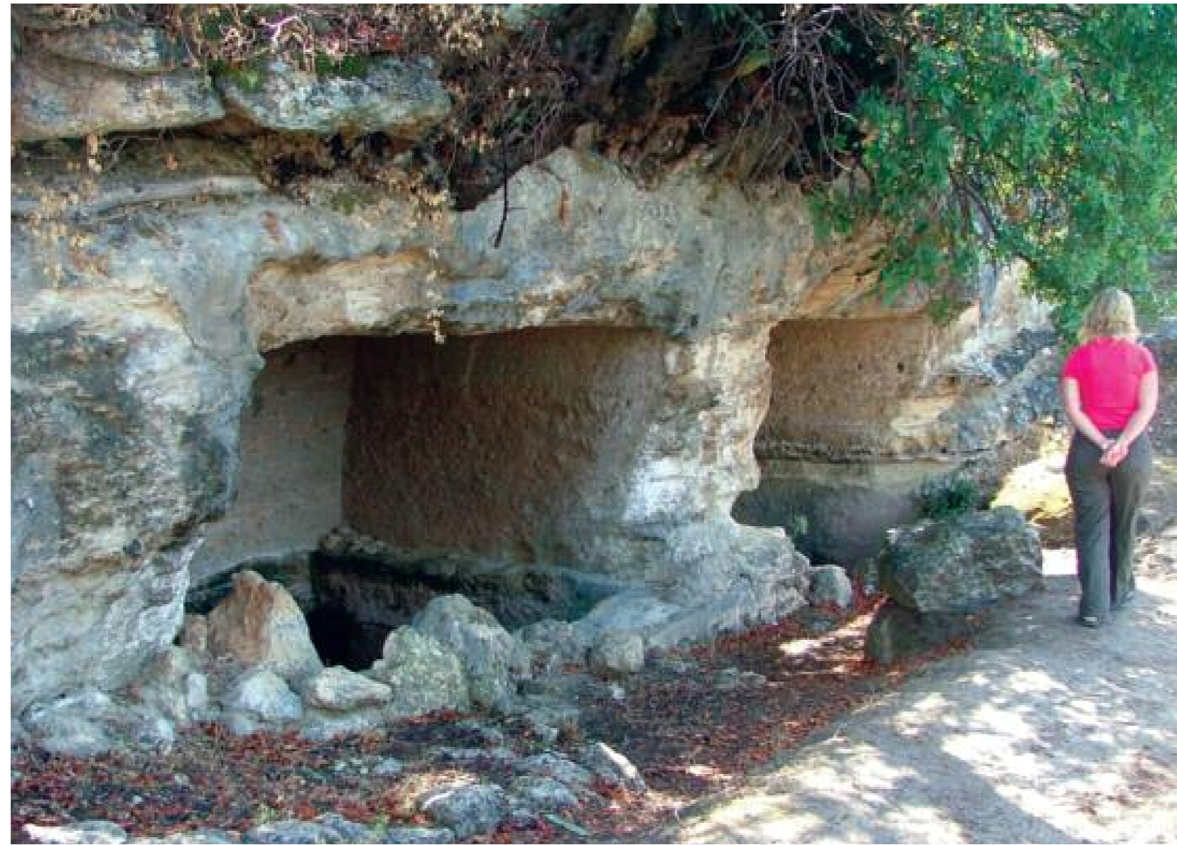
147. Υπόγειες δεξαμενές Ελεύθερνας, οι εισοδοί
