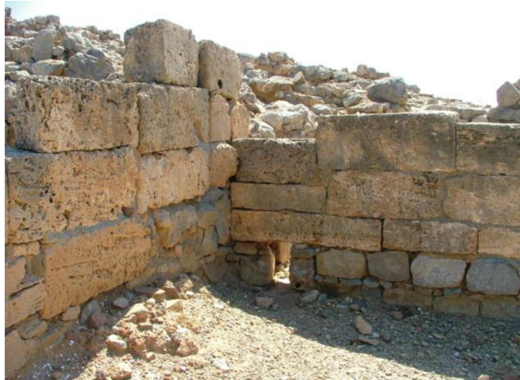
105. Ανάκτορο Ζάκρου, δόμηση με πελεκητούς λίθους
