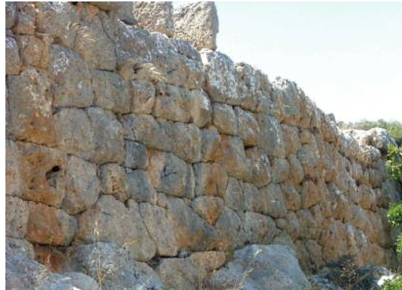
137. Τείχος κτισμένο με πολυγωνικό σύστημα από σκληρό ασβεστόλιθο Τριπόλεως
