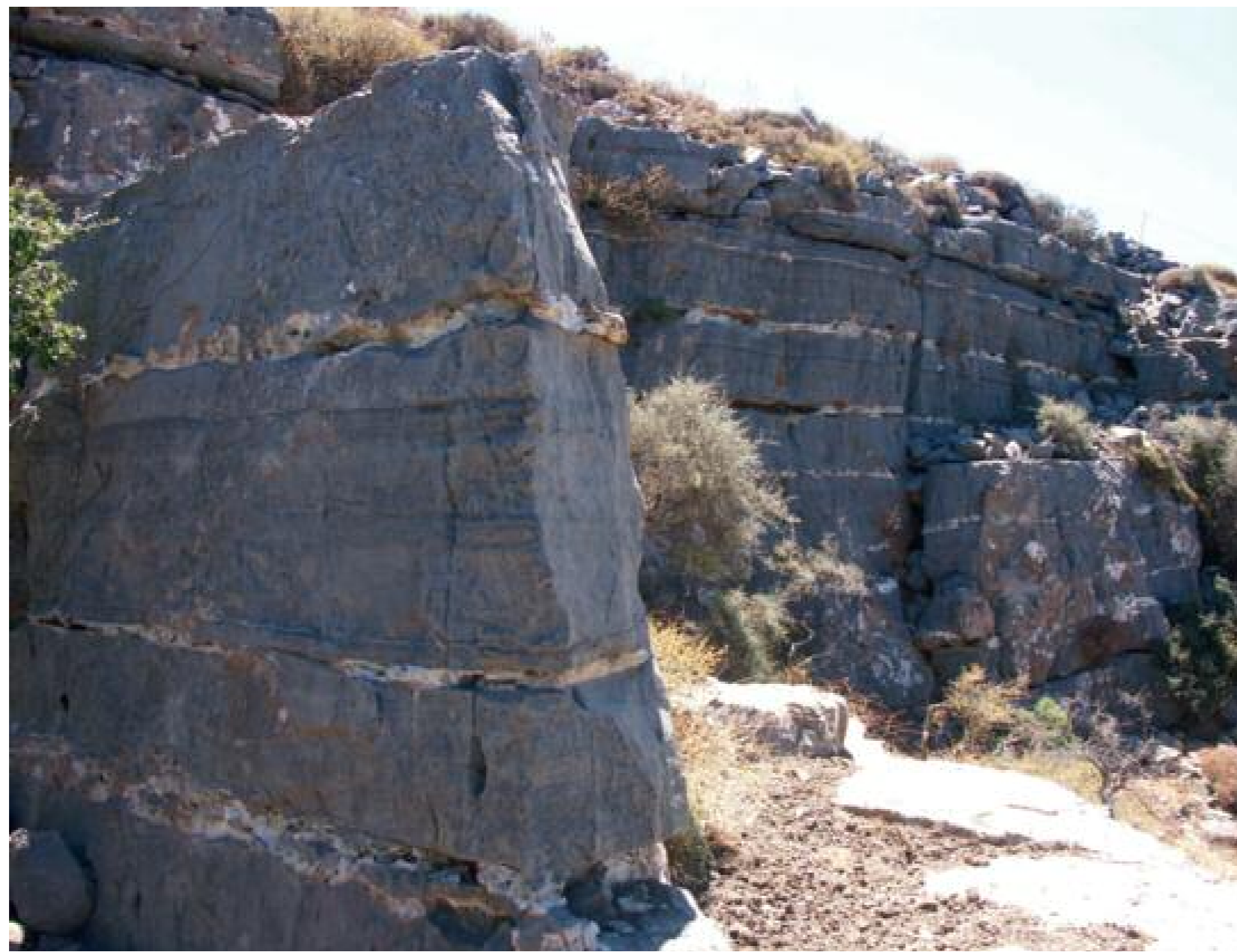
132 Πλακώδη μάρμαρα με στρώσεις πυριτόλιθων
